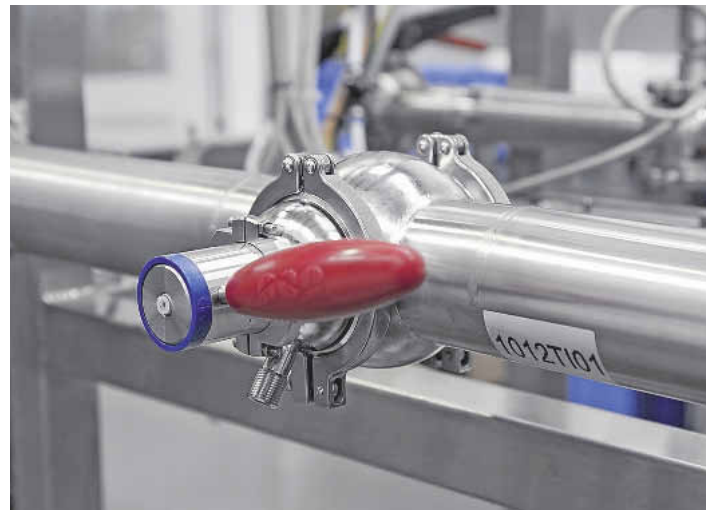
Die Antriebs- und Anschlusskonzepte können individuell an die Prozessbedingungen angepasst und jederzeit um- oder nachgerüstet werden
