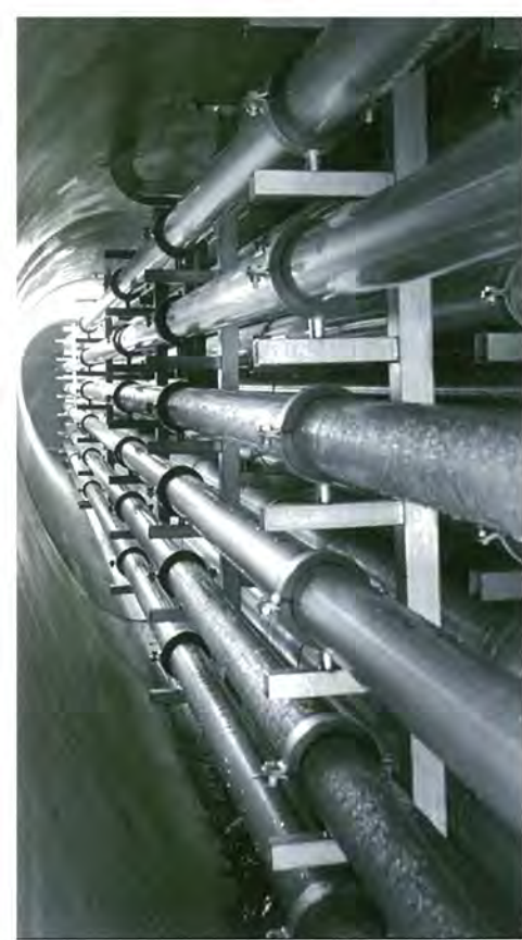
Im Tunnel herrschten beim Verlegen der Leitungen beengte Bedingungen.
