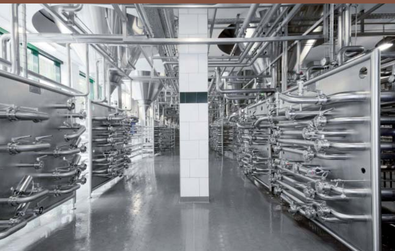
Die Vorderseite der Rohrzaunpaneele, insgesamt wurden 9,3 km Leitungen verlegt
