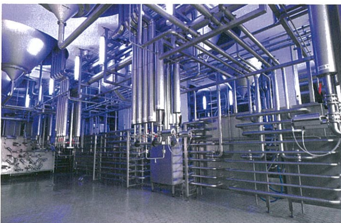
Rückansicht des Rohrzaunes im ZKL-Keller
